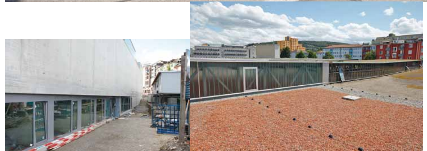
Der Erweiterungsbau schliesst sich im vorgelagerten Spickel Richtung Hallenstadion und Theater 11 dem Tramdepot Oerlikon an. Mit einem einfachen, fast monolithischen Bau antworten die Architekten auf die städtebauliche Situation, ohne dem klassischen Zweckbau von Herter Konkurrenz zu machen.
